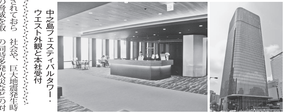
中之島フェスティバルタワー・ウエスト外観と本社受付
