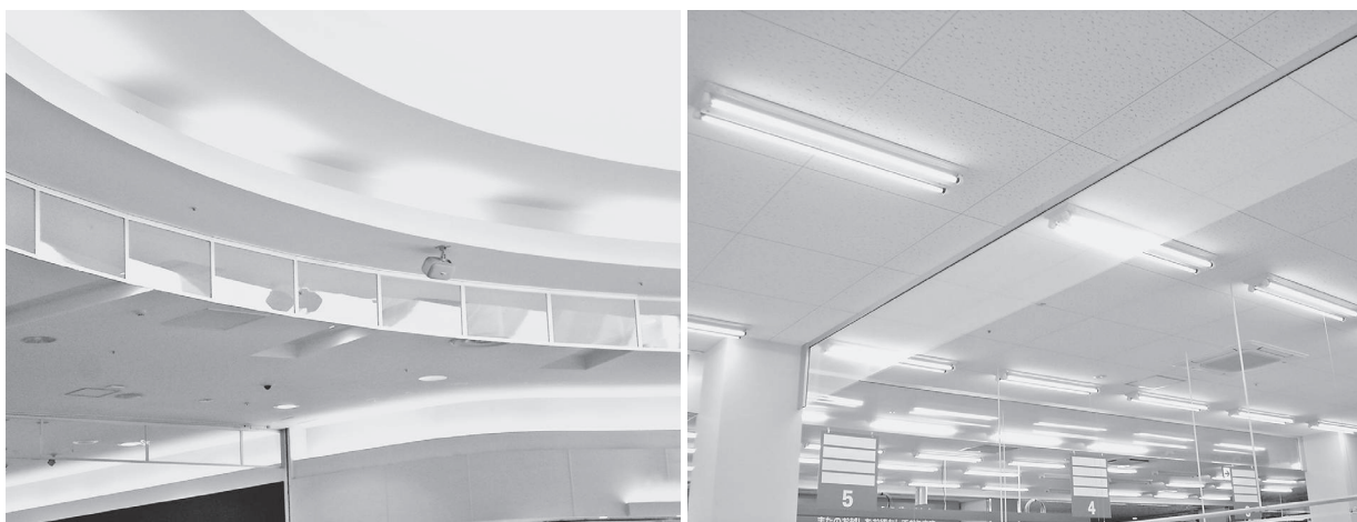
左からパネルタイプ施工例、テンションタイプ施工例
