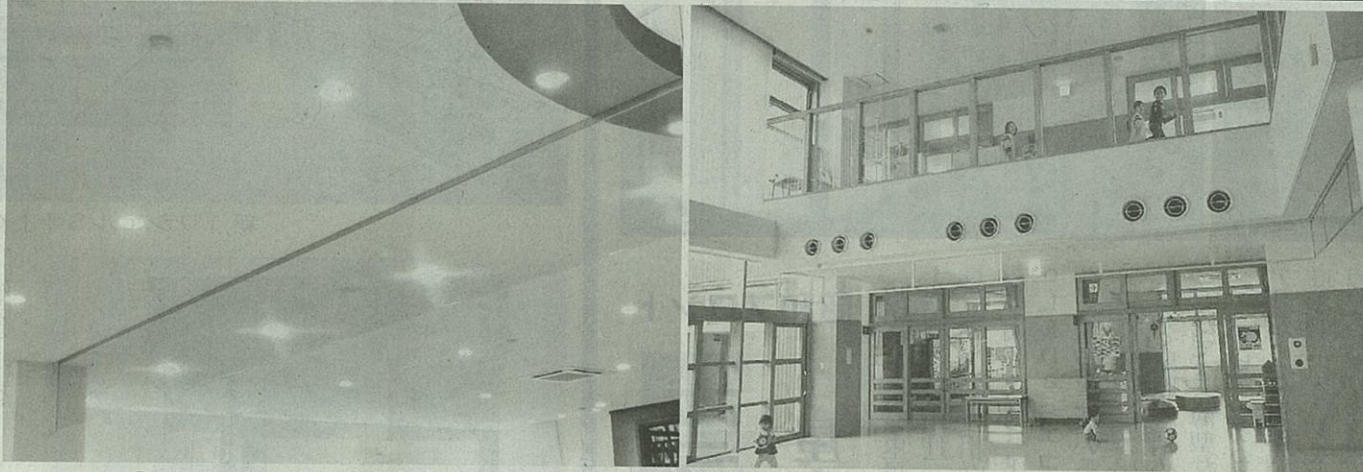
⑤「テンションタイプ」の施工例⑥「パネルタイプ」の施工例(南関こどもの丘保育園)
